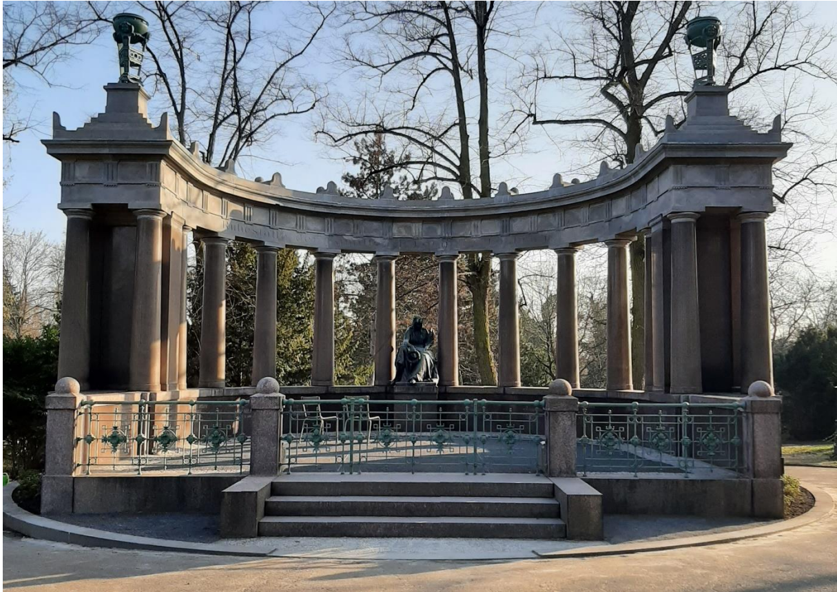
Freiluftkapelle Löblich-Liebau auf dem Alten Luisenstädtischen Friedhof nach Restaurierung, 2024 © evfbs
